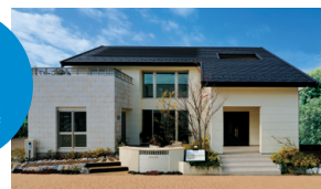
瓦一体型の太陽光パネルを搭載した 三井ホームモデルハウス
