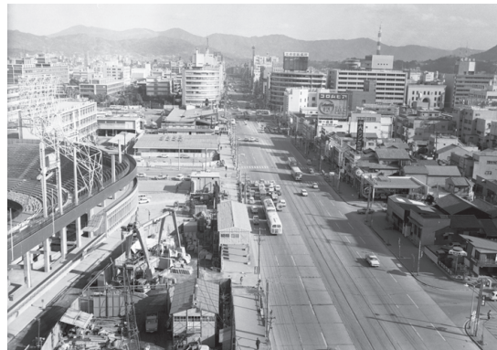
1970(昭和45年) 商工会議所屋上から
