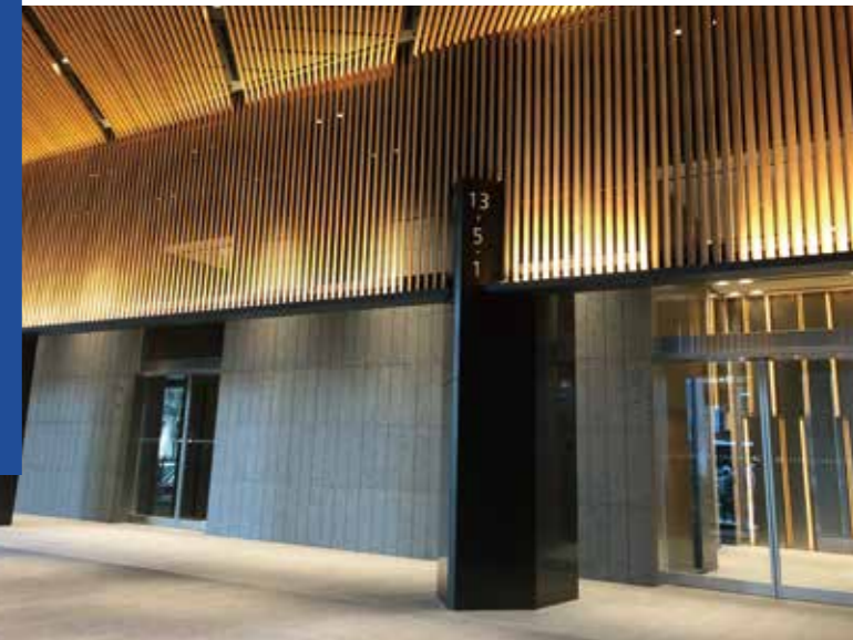
名古屋三井ビルディング北館(エントランス)
